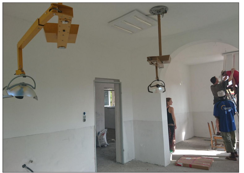
Auf dem Gelände der Schule entsteht eine Zahnarztpraxis.
